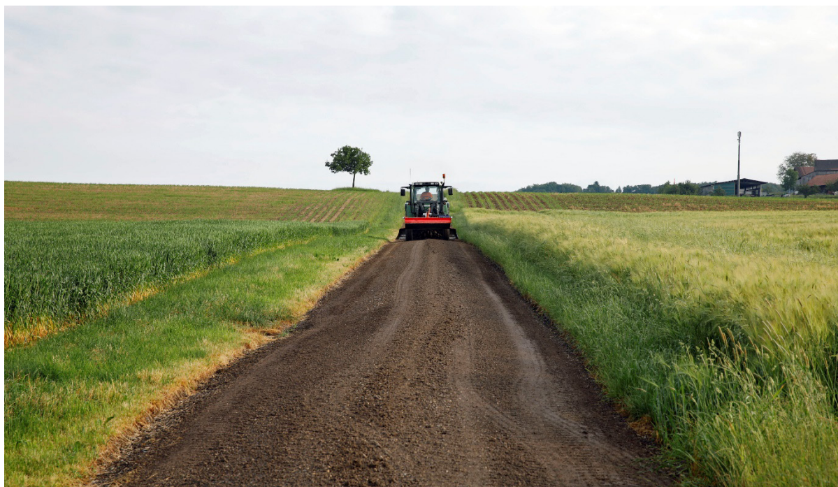
Einbringen einer Verschleisschicht (RC B 0-22).
