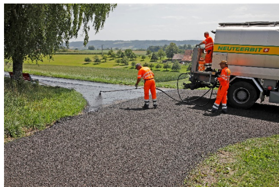
Durchführen einer Oberflächenbehandlung (OB)
