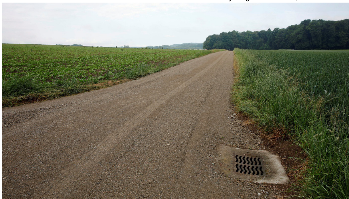
Eine Kiesstrasse nach der Sanierung.
